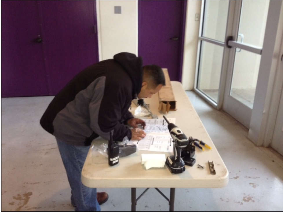
ERHS – Jimmy Salutan Replaces the Gymnasium Door Hardware
