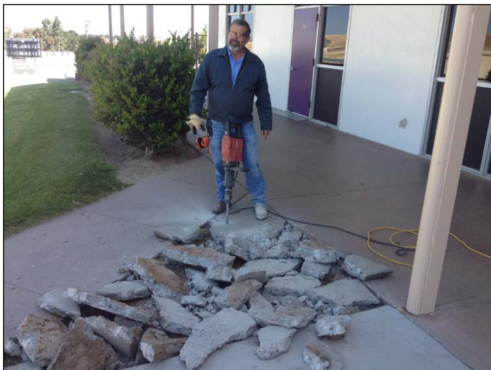
ERHS – José Placencia corrects a Tripping Hazard
