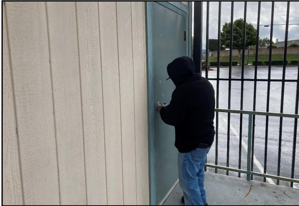
ERHS –Jimmy Salutan Repairs a Door Lock
