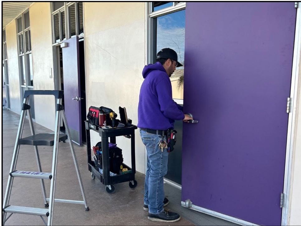
ERHS – Armando Gutierrez Repairing Door Hardware
