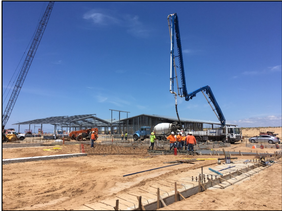
CTE Ag Center – Barn Foundation Concrete Pour Underway
